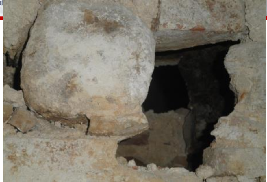
Caratteristiche scadenti delle murature
