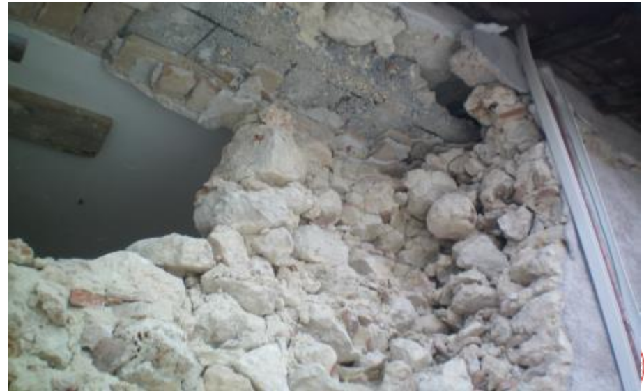
Caratteristiche scadenti delle murature
