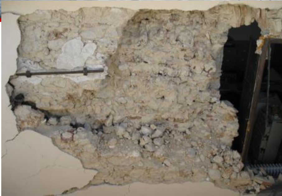
Caratteristiche scadenti delle murature
