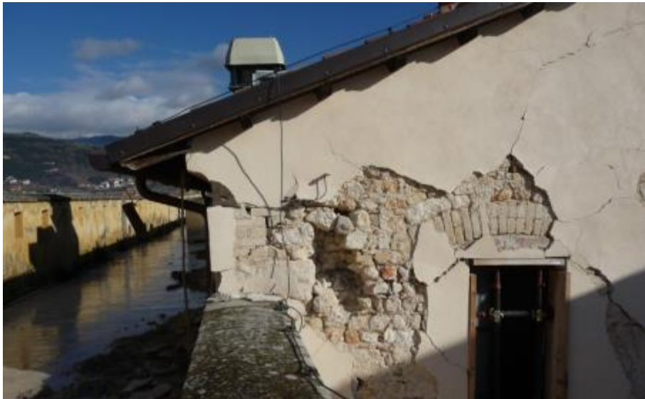
Caratteristiche scadenti delle murature
